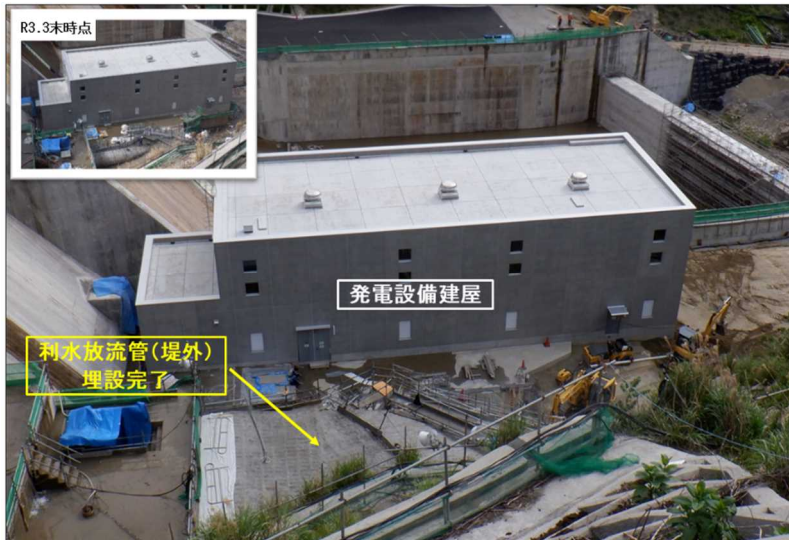
利水放流設備の施工状況
