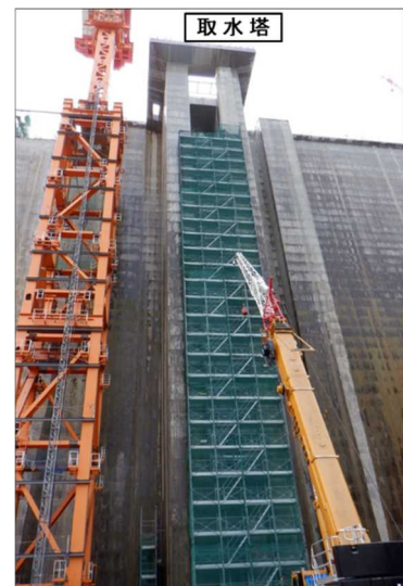
取水設備の施工状況
